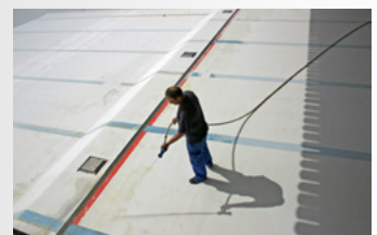
Teich- und Poolreinigung Restwasser-Entfernung nach Entleerung mit Pumpe
